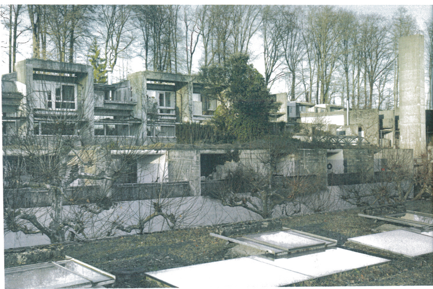
Blick von den Dächern über den Dorfplatz mit seinen alten Platanen: Müssen sie für den Kran gefällt werden?
